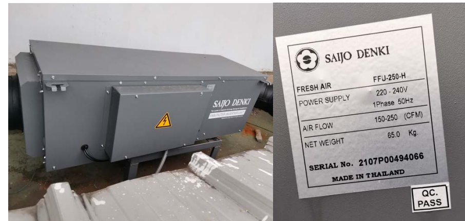
รูปแสดงชุดเครื่องระบายลมออกจากห้อง
