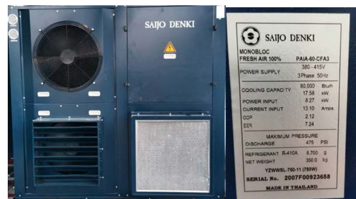
รูปแสดงชุดเครื่องปรับอากาศสำหรับจ่ายลมเข้าห้อง เครื่อง 2
