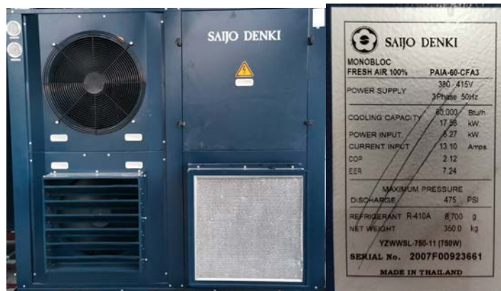
รูปแสดงชุดเครื่องปรับอากาศสำหรับจ่ายลมเข้าห้อง เครื่อง 1
