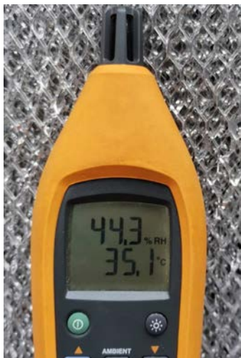
รูปวัดสภาวะอากาศเข้าสู่ชุดเครื่องปรับอากาศสำหรับจ่ายลมเข้าห้อง เครื่อง 1
