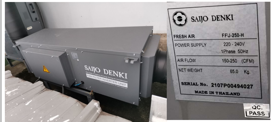
รูปแสดงชุดเครื่องระบายลมออกจากห้อง
