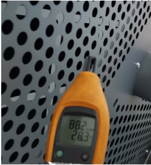
รูปวัดสภาวะอากาศเข้าสู่ชุดเครื่องปรับอากาศสำหรับจ่ายลมเข้าห้อง
