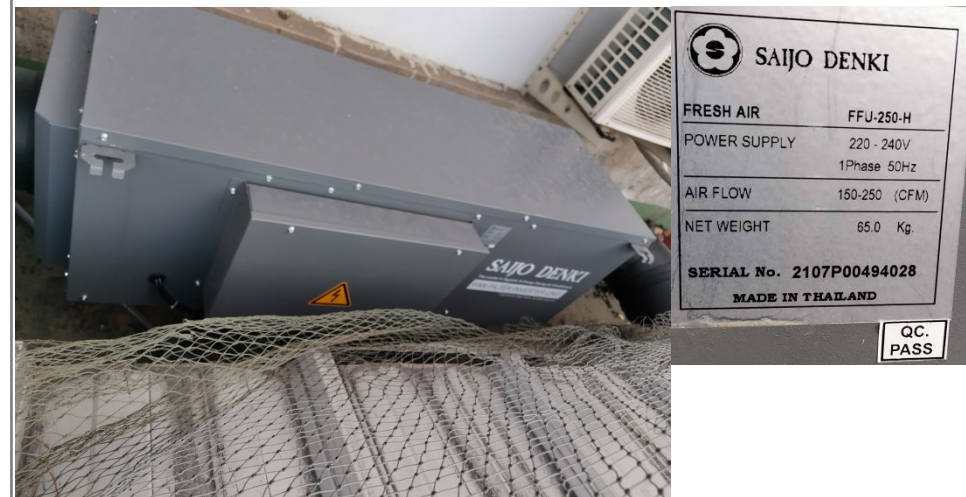
รูปแสดงชุดเครื่องระบายลมออกจากห้อง
