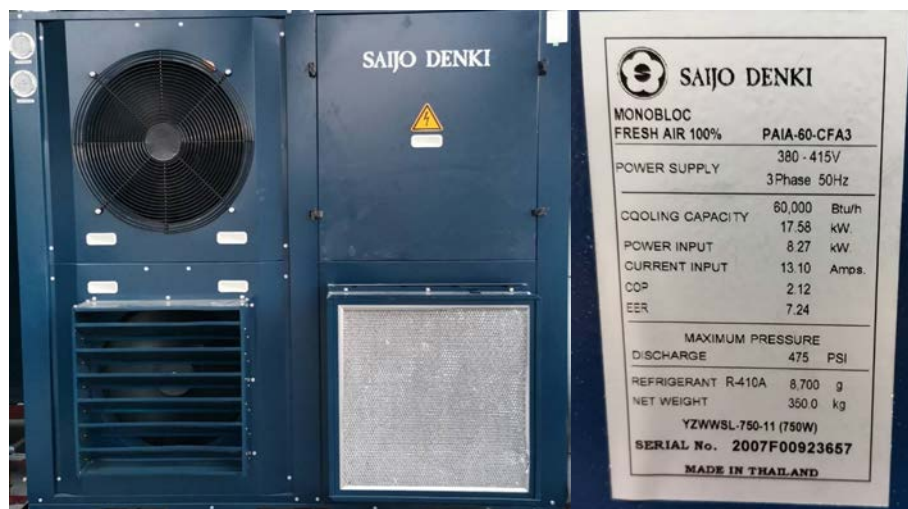
รูปแสดงชุดเครื่องปรับอากาศสำหรับจ่ายลมเข้าห้อง
